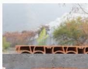
**4.** Oriente los huecos de Barro Kappa en el sentido de la pendiente de la losa para el libre flujo del agua de lluvia.
